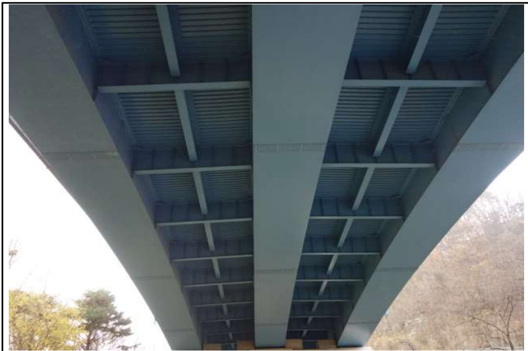
STB 거더 구간 하면 전경
