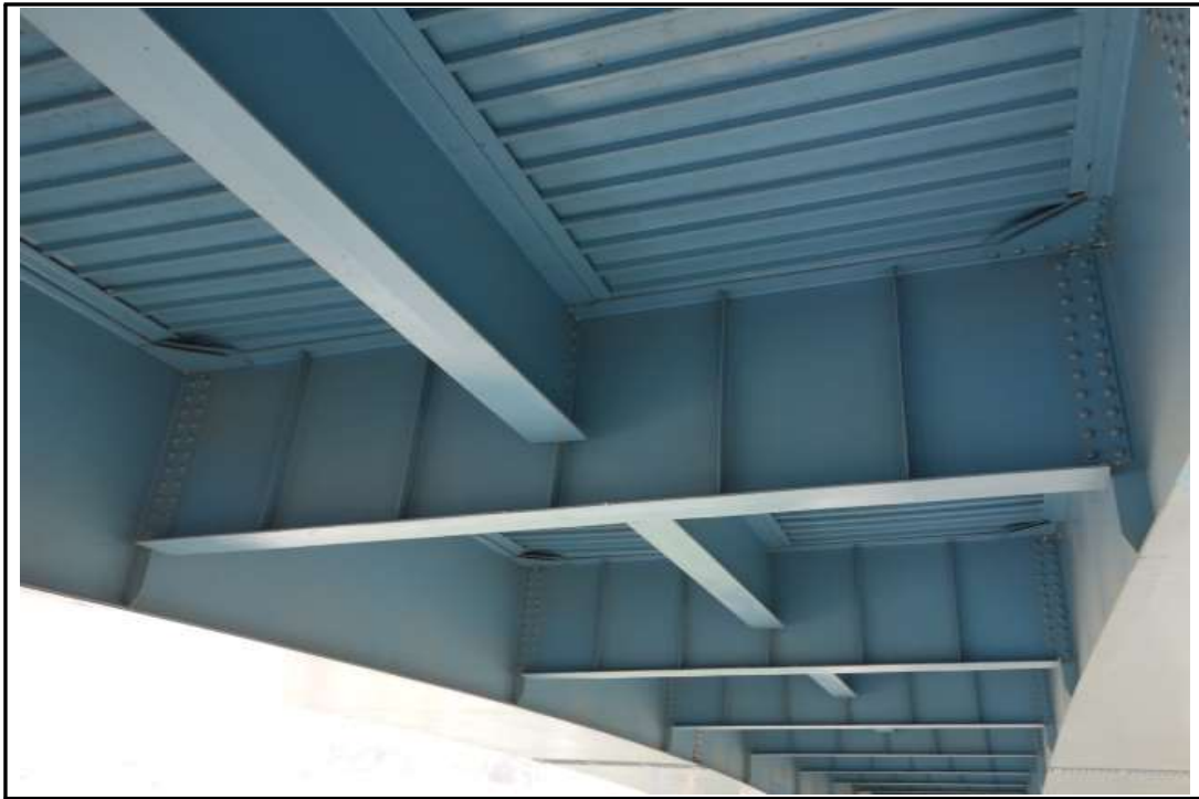
STB 거더 구간 가로보 전경
