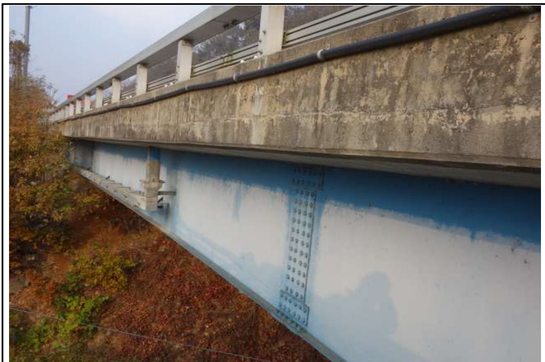
STB 거더 구간 측면 전경
