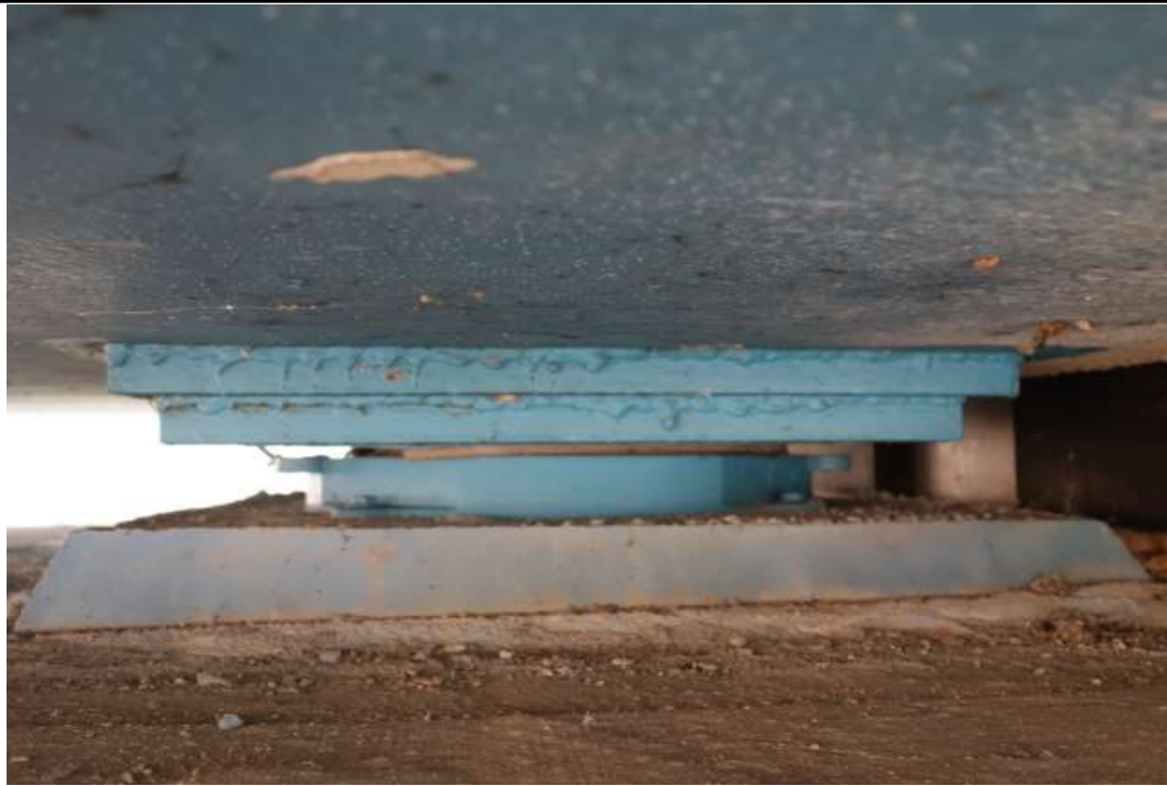
교량받침 전경 (포트받침)
