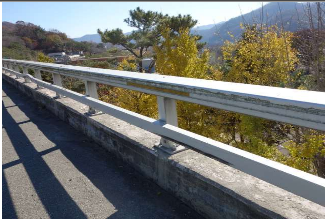
난간 및 연석 전경
