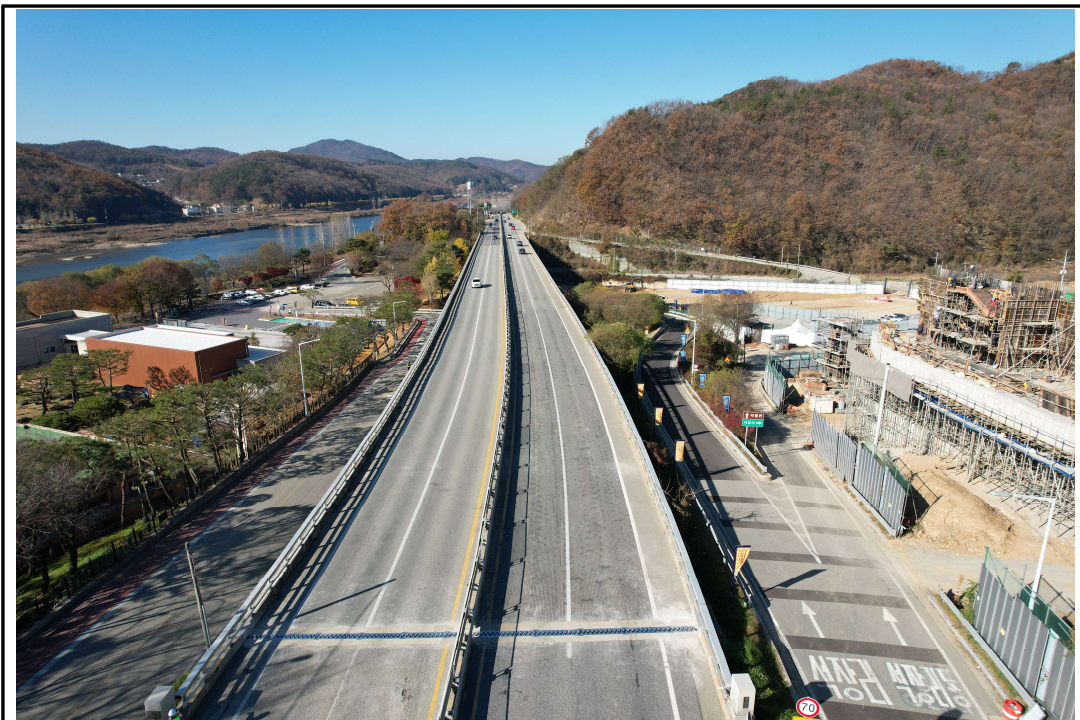
교면포장 및 중앙분리대 전경
